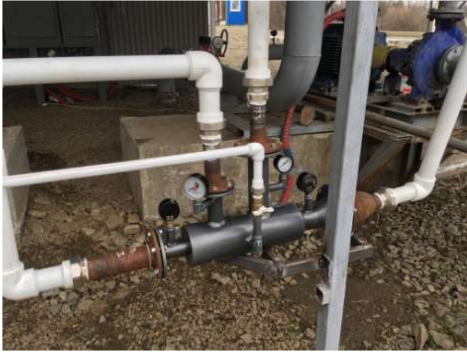
Рисунок 4.1 – Ввод удобрений в сеть с помощью четырёхкомпонентного струйного смесителя. (Общий вид)
