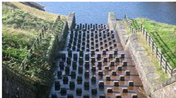
Рисунок 1.2 – Многоступенчатый перепад с шашками водосброса из водохранилища Yeoman Res, Великобритания
