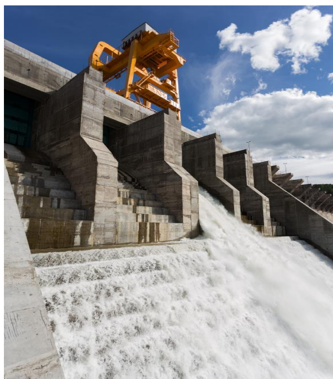
Рисунок 1.16 – Водосливная плотина Богучанской ГЭС со ступенями на сливной грани
