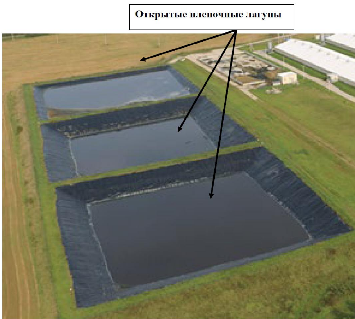
Рисунок 8. Общий вид лагун с пленочной гидроизоляцией.
